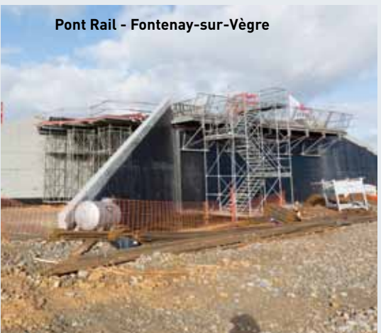
Pont Rail - Fontenay-sur-Vègre
