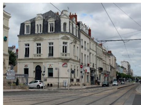
Immeubles au nord de la gare d'Angers. Crédit photo : ESO Le Mans.
